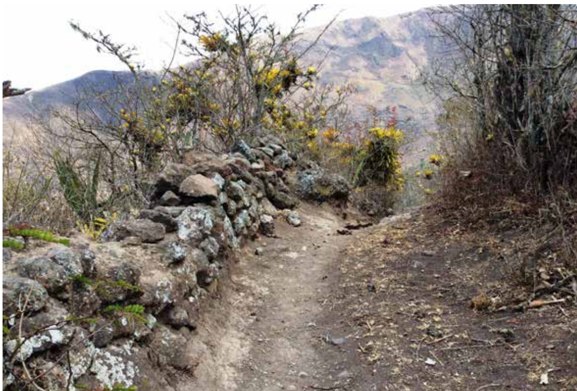
Fig. 85. Sección de camino Juan Montalvo – Cabuyal, provincia del Carchi, Ecuador. Llegando a la frontera con Colombia, el camino longitudinal de la sierra reduce sus dimensiones y desaparecen sus finas características constructivas. Instituto Nacional de Patrimonio Cultural del Ecuador, foto Fredy Ramos
