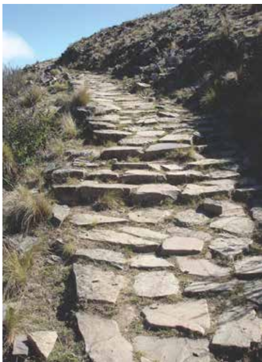
Fig. 105. Subsección Santa Ana - Valle Colorado, tramo Quebrada Grande - Las Escaleras. Foto Qhapaq Ñan Argentina (Ar-Qge-01 / C-2011).
