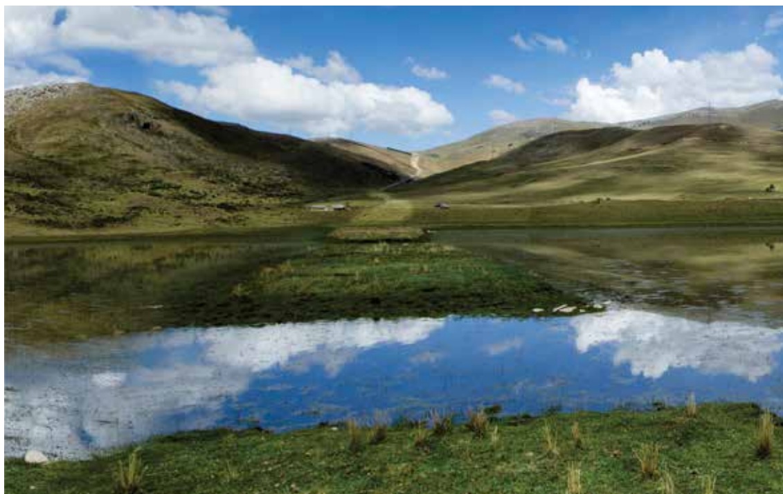
Fig. 68. Camino del subtramo Acostambo - Huanuco Pampa, que cruza la laguna Goytoc con calzada elevada y drenajes intermedios que debieron ser cubiertos por puentes, en las inmediaciones del centro administrativo de Huánuco Pampa. Foto Yanoa Pomalima Carrasco, Qhapaq Ñan Perú.
