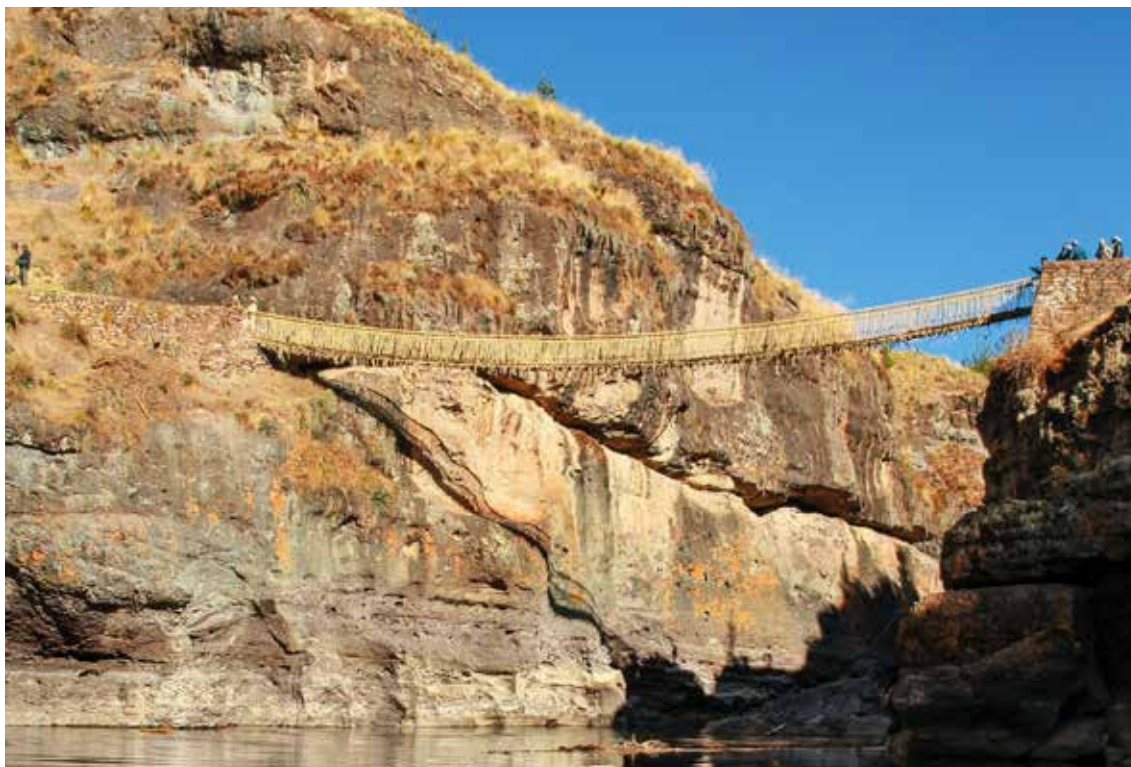
Fig. 78. Puente Q'eswachaka sobre el cañón del río Apurímac, Cusco, Perú. Foto Qhapaq Ñan Cusco.
