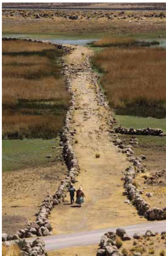
Fig. 71. Tramo del camino con muros laterales en Pomata, cruzando humedales cubiertos con totorales. Puno, Perú. Foto Qhapaq Ñan Perú.
