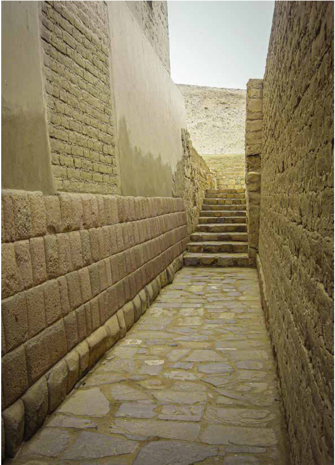
Fig. 145. Sin embargo, sobresale el uso de mampostería de piedra en los sobrecimientos de fino tallado estilo inca. Foto archivo del Museo de Pachacamac, Ministerio de Cultura del Perú.
