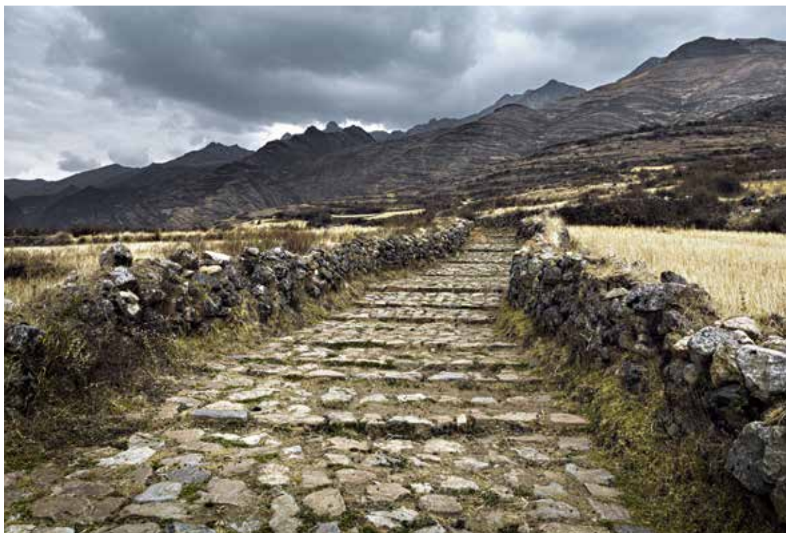
Fig. 82. En su recorrido hacia el norte, el camino longitudinal de la sierra mantiene una arquitectura magnífica, con piso empedrado y drenajes bien acabados, y muros laterales de fina confección. Tramo de camino inca en Soledad de Tambo, departamento de Ancash. Foto José Luis Matos Munasqui, Qhapaq Ñan Perú.
