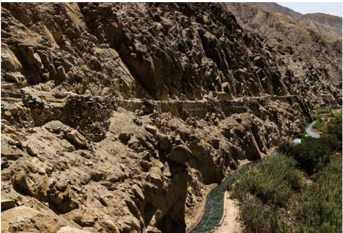
Fig. 139. Los caminos transversales que bajan por los valles corren por la mitad de las laderas, sobre “plataformas colgantes” con muros de contención. Camino en la zona arqueológica La Toma, valle de Cañete. Foto José Luis Díaz, Qhapaq Ñan Perú.
