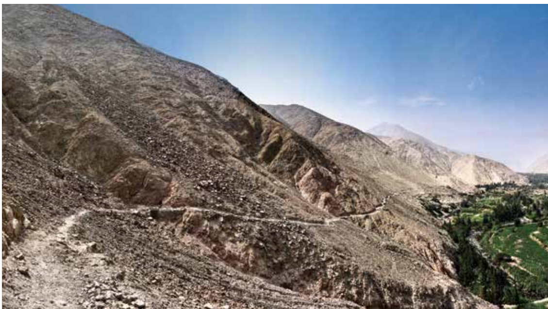
Fig. 141. Detalle del tramo transversal pasando por Chontay. Nótese el uso de las laderas para protegerse del comportamiento del río, así como para no afectar las áreas productivas. Foto Qhapaq Ñan Perú.
