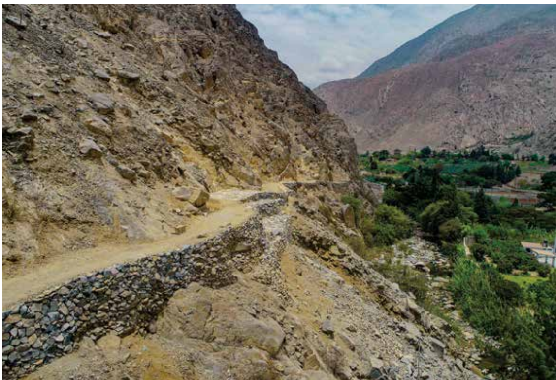
Fig. 142. Tramo de camino transversal inca en la quebrada de Canturillas, departamento de Lima, en la zona de Nieve Nieve, algunos kilómetros más abajo que Chontay. Nótese la técnica constructiva en plataformas. Foto Gerardo Quiroga, Qhapaq Ñan Perú.
