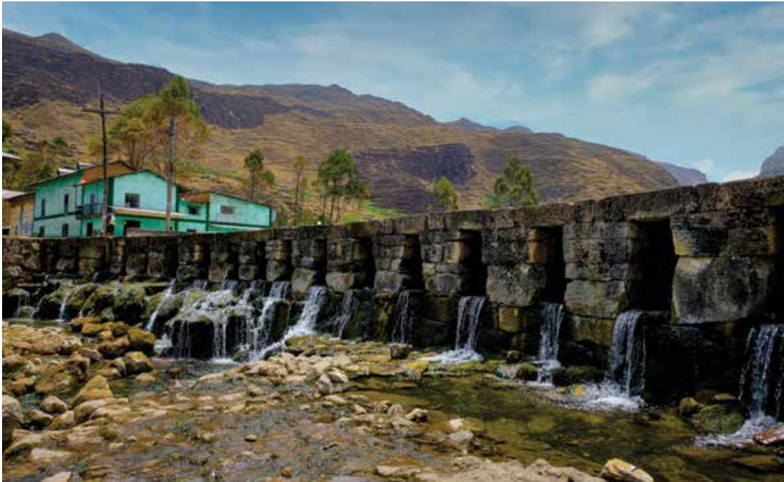
Fig. 160. A diferencia del puente Q'ewwachaka, colgante y construido a base de fibra vegetal, el puente de filiación inca en Huarautambo, departamento de Pasco, es de bloques de piedra y corre muy próximo a las aguas del río. Foto Ivan Ccachura, Qhapaq Ñan Perú.
