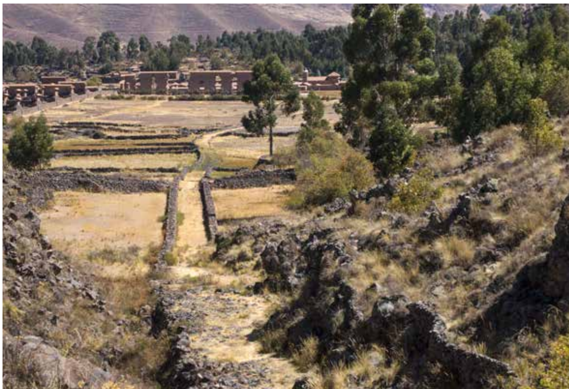
Fig. 109. Camino delimitado por muros saliendo a Raqchi. Sección del tramo Cusco - Desaguadero, provincia de Canchis, Cusco, en el camino al Qollasuyu. Foto Qhapaq Ñan Cusco.
