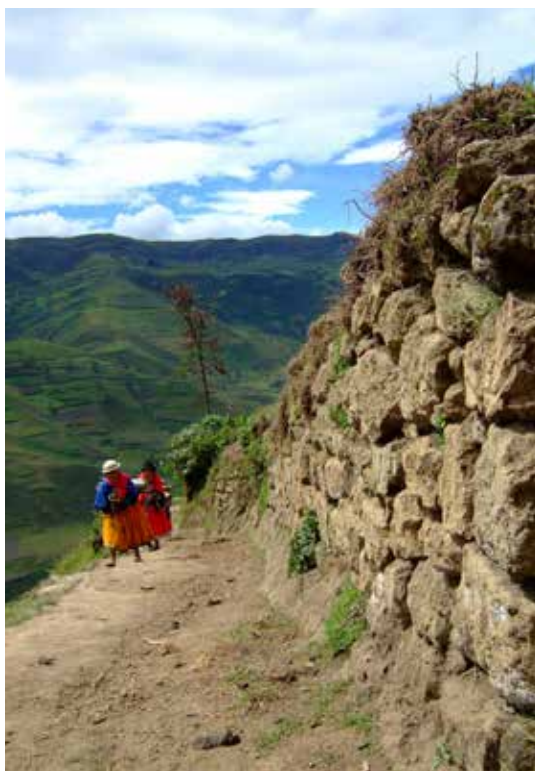
Fig. 113. Sección del camino Shuid - La Moya, cantón Alausí, provincia de Chimborazo. Talud alto para proteger camino en ladera. Instituto Nacional de Patrimonio Cultural del Ecuador. Foto Fernando Espinoza.
