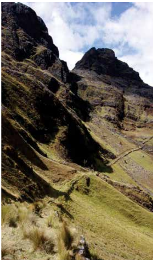
Fig. 7. Sección Escalerilla -Casa Blanca - Cerro Huaylillas - Cushuro, camino en plataforma con muro de contención. Foto Qhapaq Ñan Perú.
