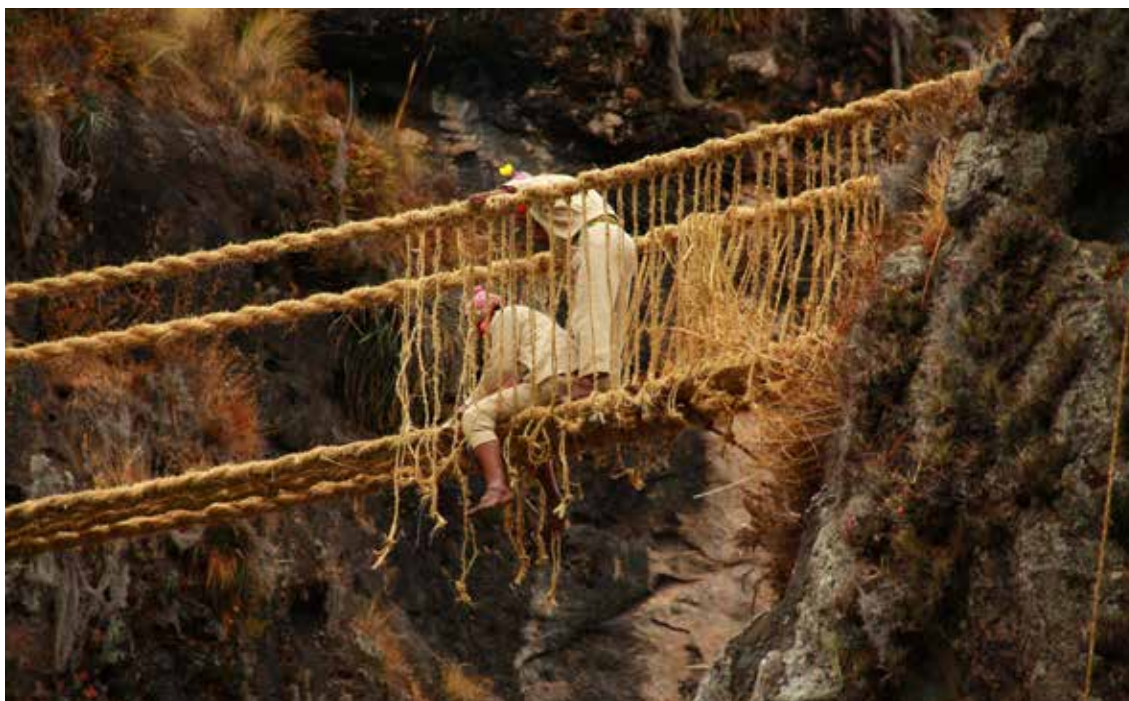
Fig. 159. Detalle del mantenimiento anual que las comunidades aledañas hacen al puente Q'eswachaka sobre el cañón del río Apurímac, Cusco, Perú. Foto Qhapaq Ñan Cusco.
