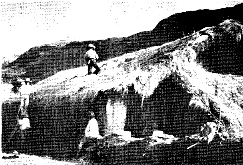
Cambiando el techo de la casa.
