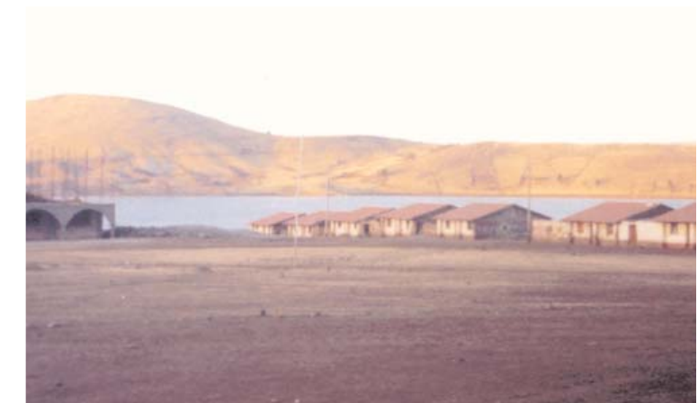
Foto 5. Represa del Proyecto Cachi y local comunal en construcción.
