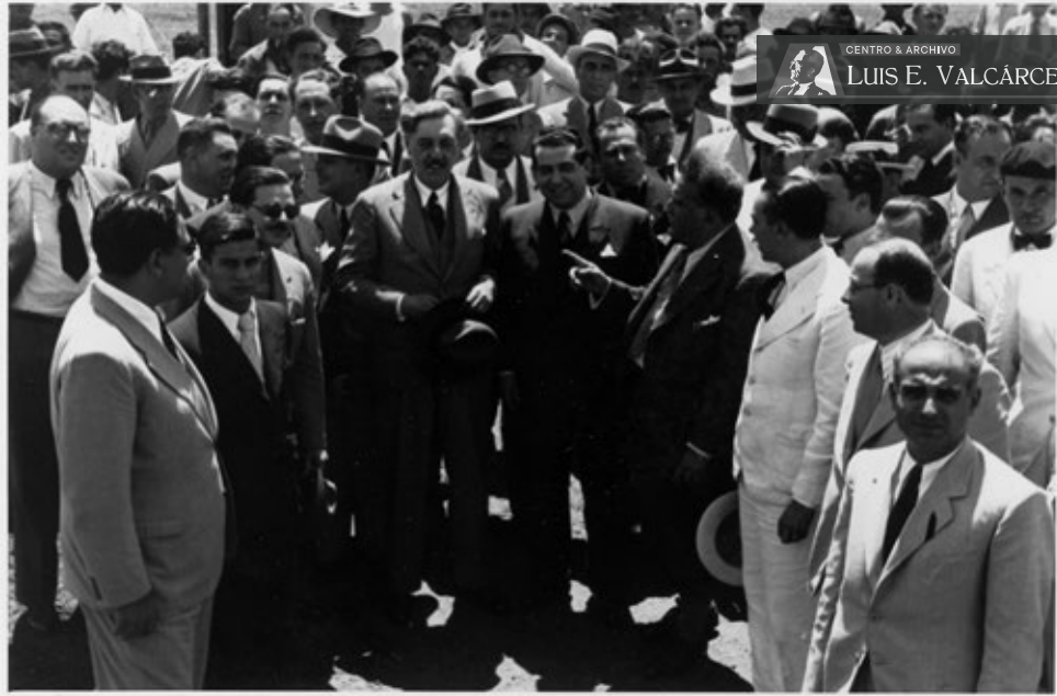
Reunión en Montevideo (RM-108).jpg Recorriendo las obras del Río Negro
