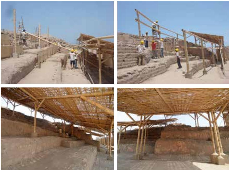
Fotos de procedimiento de instalación de la cubierta del Templo Pintado
