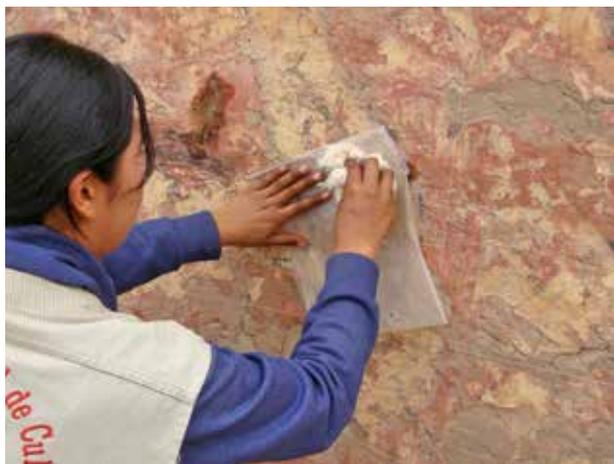
Consolidación de acabados: humectación con *spray* y readherencia de capas
