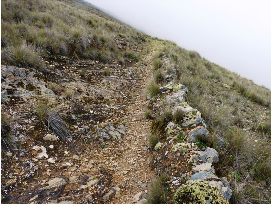
Img. 13: vista de detalle de la conformación del canal secundario. Nótese el terraplén artificial construido en el lado derecho y el talud del cerro al otro extremo.
