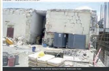
Daños. Habrían derruido muro y pileta para construir centro comercial. Fiscal constató trabajos para un sótano
