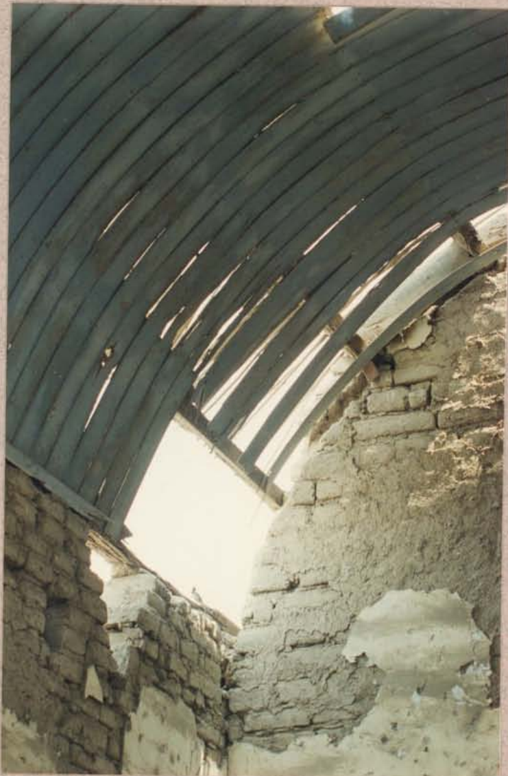
DETALLE DE BOVEDA (INTERIOR)
