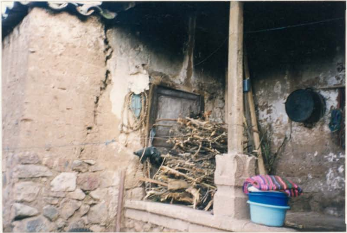
FOTOGRAFIA N°5 ESTADO ACTUAL DE AMBIENTES QUE CONFORMAN EL PATIO
