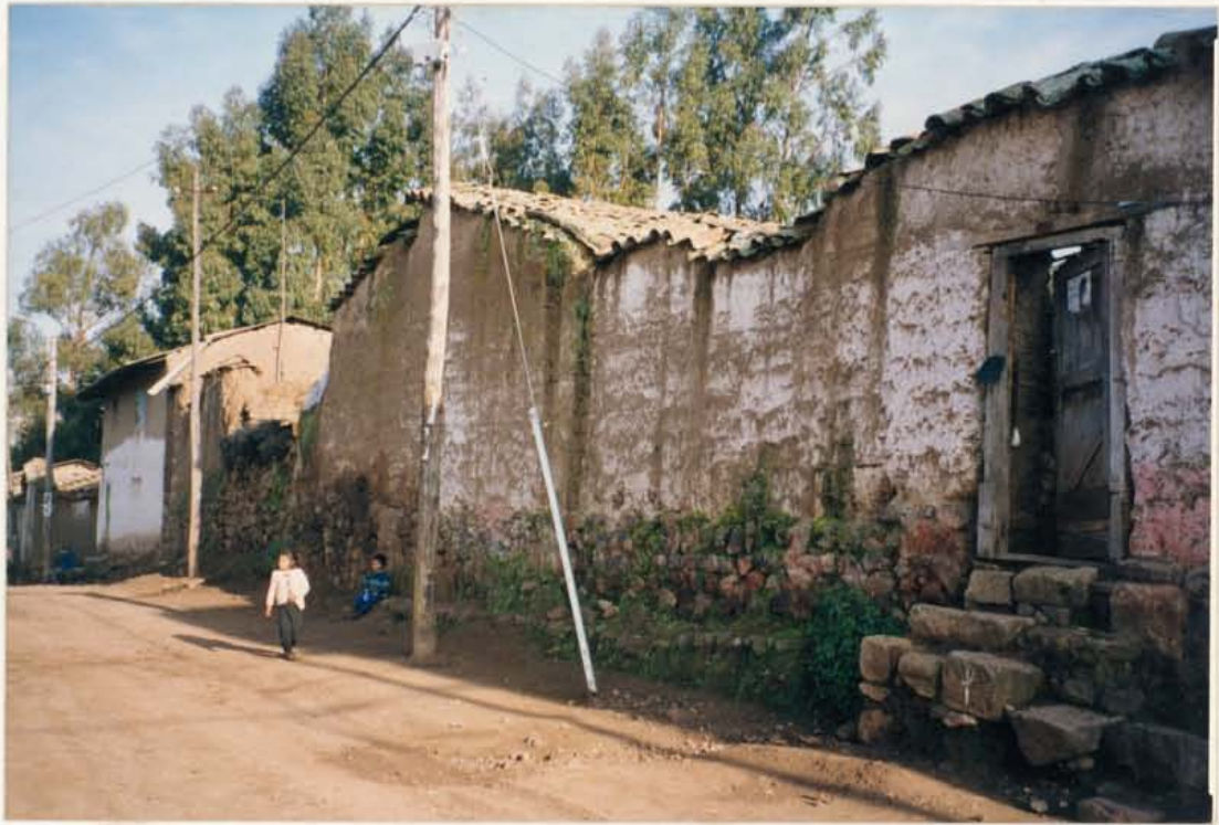
FOTOGRAFIA N° 7 PUERTA DE INGRESO A RESTITUIR
