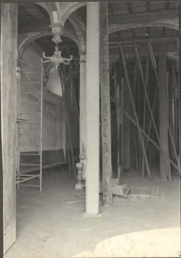
FOTO N° 10 VISTA INTERIOR DE LA NAVE. OBSERVE SE EL APUNTALAMIENTO EN AREA CRITICA POR DEPRESION DEL TECHO.
