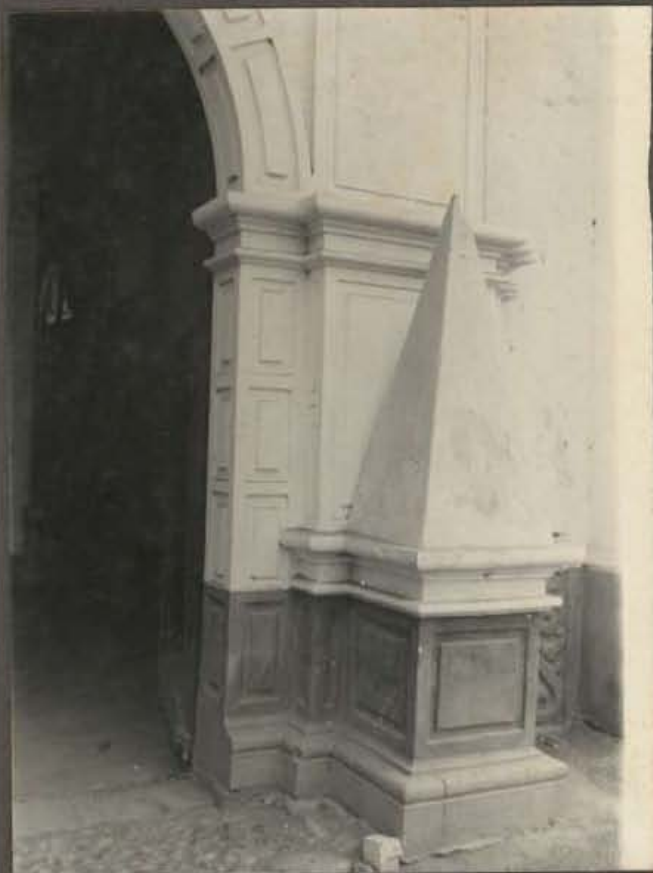
FOTO N°19 LADO IZQUIERDO DEL INGRESO PRIN- CIPAL DE LA CAPILLA
