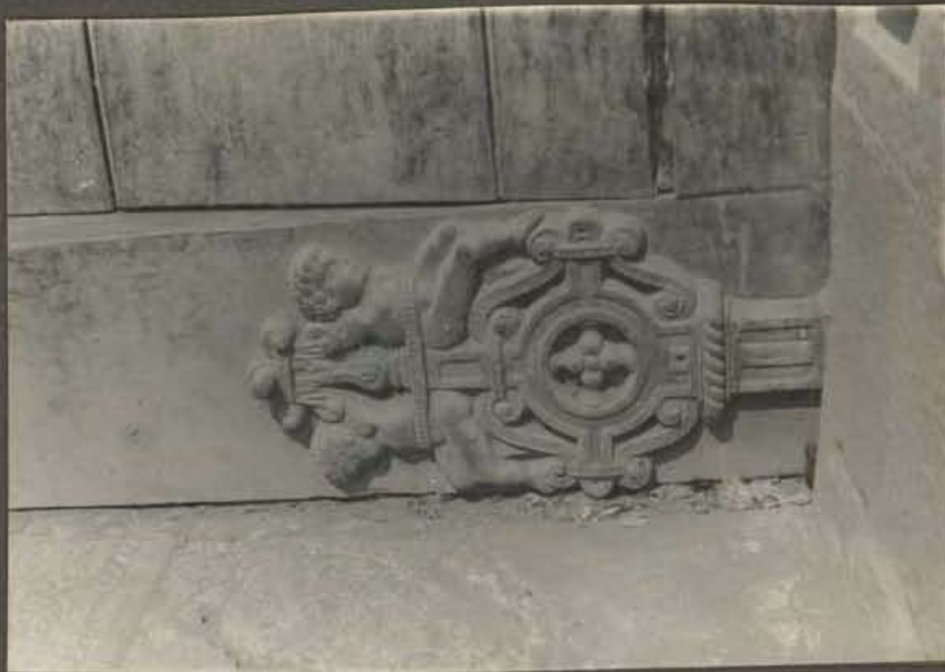
FOTO N°23 DETALLE DE PUERTA PRINCIPAL DE LA CAPILLA, UBICADO EN LA PARTE IN- FERIOR Y ES FIERRO. ES AUTENTICO.
