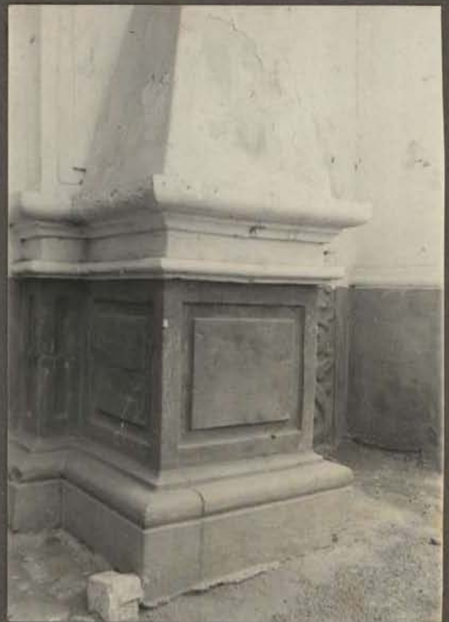
FOTO N°20 DETALLE DE ENCUENTRO DE PISO EX- TERIOR CON PARED DE LA FACHADA PRINCIPAL DE LA CAPILLA
