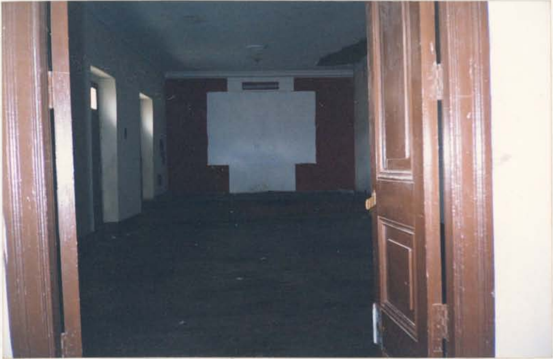
SALÓN AUDITORIO SEGUNDO PISO.
