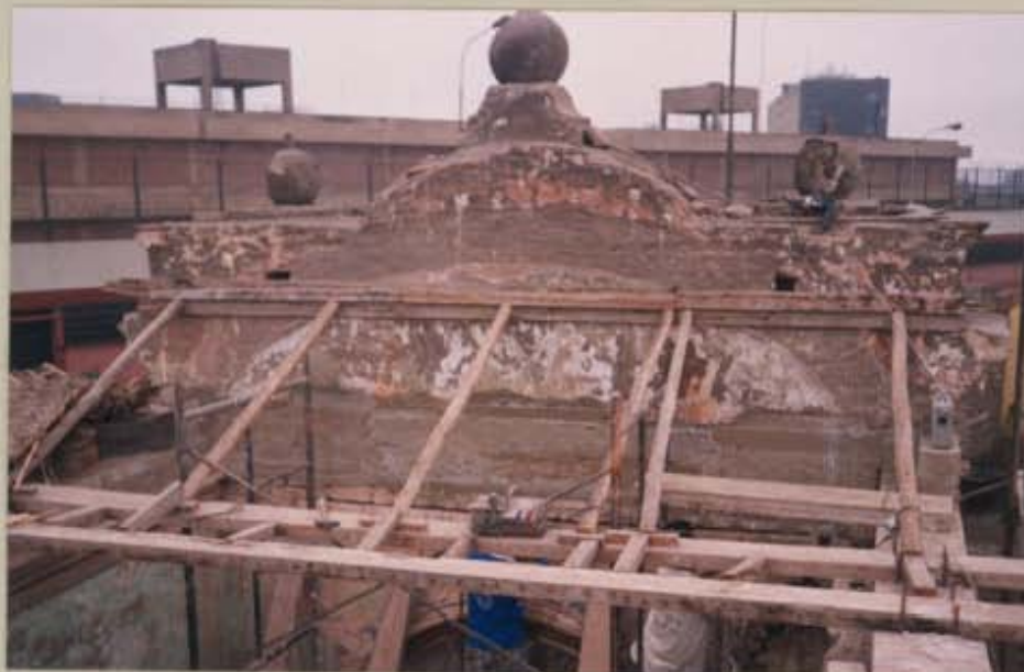
• Aplome y consolidación de fachada de capilla.
