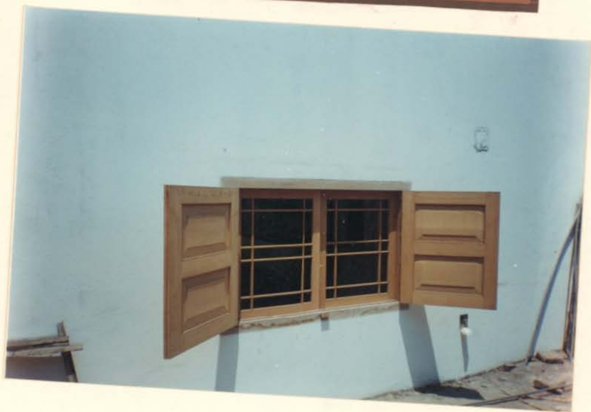
RESTITUCION DE VENTANAS BAJAS EN MUROS LATERALES DE CAPILLA. INICIO PARA EL PINTADO DE PUERTAS Y VENTANAS CON BASE DE PIROXILINA Y ESMALTE SATINADO. EL COLOR EN BASE A EVIDENCIA.
