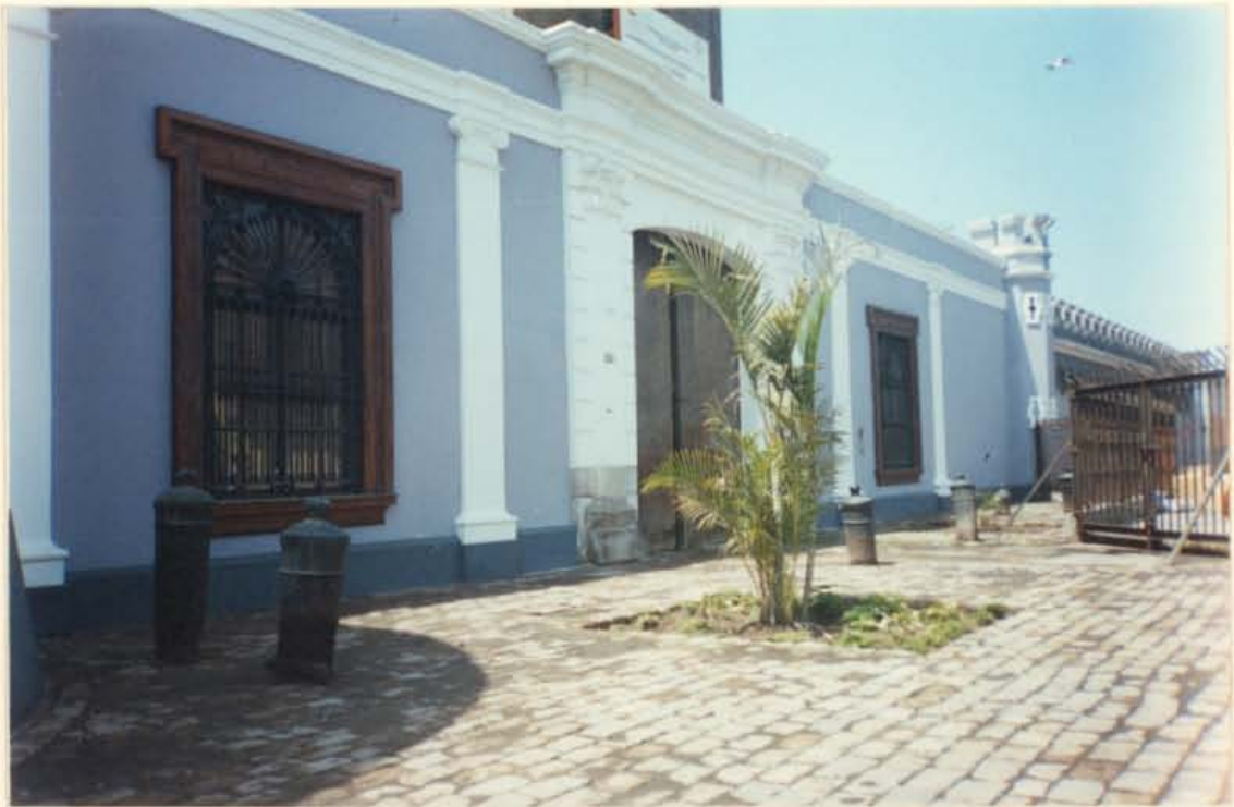
FACHADA PRINCIPAL ACABADO MEDIANTE PINTURA DOS CAPAS EN MUROS Y MOLDURAS, PREVIA LIMPIEZA, LIJADO, SELLADO Y RESANE.
