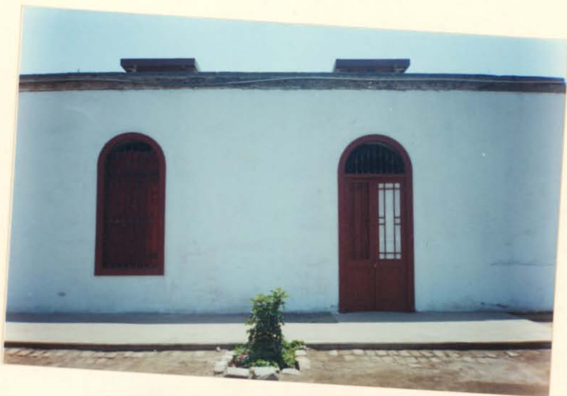
RESTITUCION DE VENTANAS BAJAS EN MUROS LATERALES DE CAPILLA. INICIO PARA EL PINTADO DE PUERTAS Y VENTANAS CON BASE DE PIROXILINA Y ESMALTE SATINADO. EL COLOR EN BASE A EVIDENCIA.
