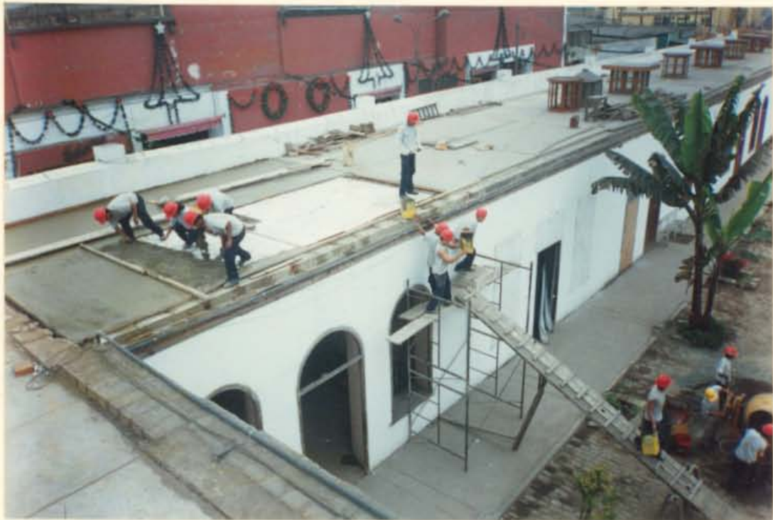
PROCESO DE VACIADO DE LOSA LLENA LIVIANA \approx 400 Cm. EN AMBIENTE 104 - TAJINAR DE HIDRATACION DEL CONCRETO
