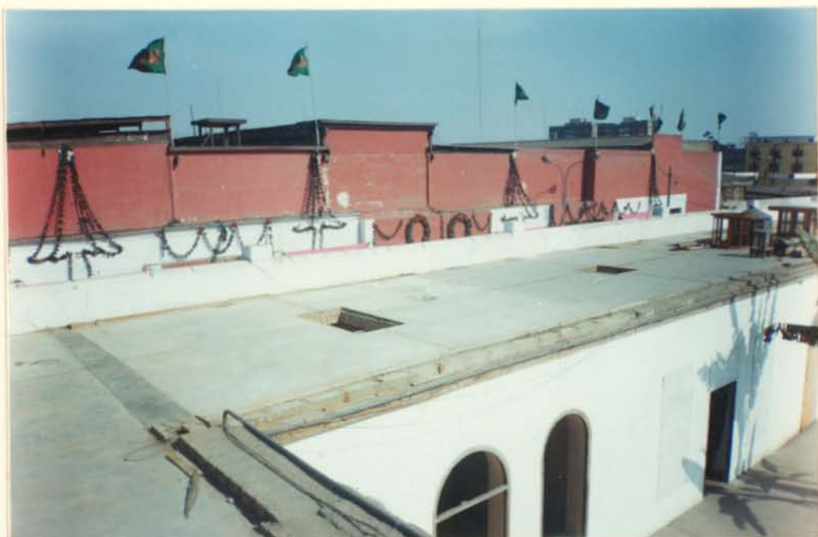
RESTITUCIÓN DE COBERTURAS DE AMBIENTES 104 Y 105 INTERVENCIÓN DE PARAPETO EN MUROS COLINDANTES CON EL JIRÓN ANDAHUAYLAS MEDIANTE TRABAJOS DE RESTITUCIÓN, CONSOLIDACIÓN , ENLUCIDO E IMPRIMADO.
