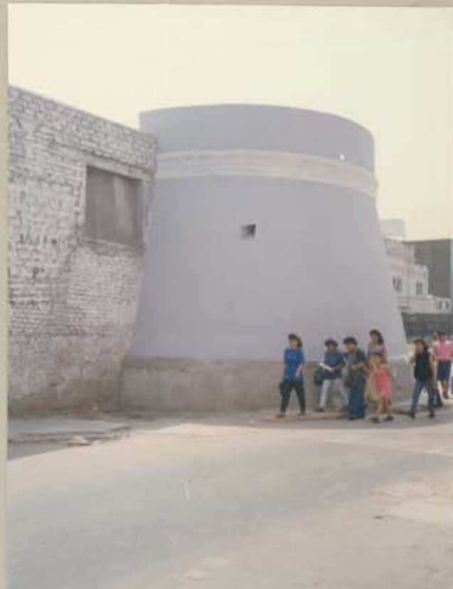
Vistas del torreón en la primera intervención, y en 1998 durante los trabajos de consolidación de zócalo.
