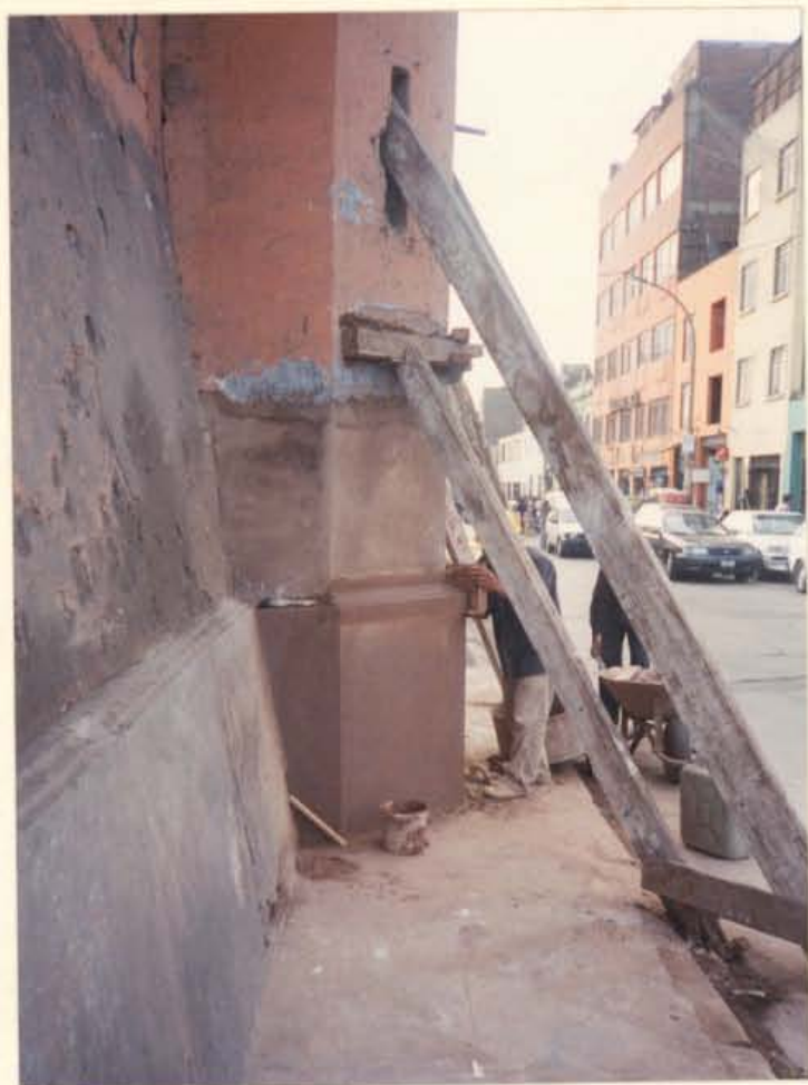
RESTITUCIÓN DE MOLDURAS MEDIANTE TARRAJA SOBRE CAJECERA DE BASE EN TORRETA - TRABAJO CONCLUIDO EN TORRETA.
