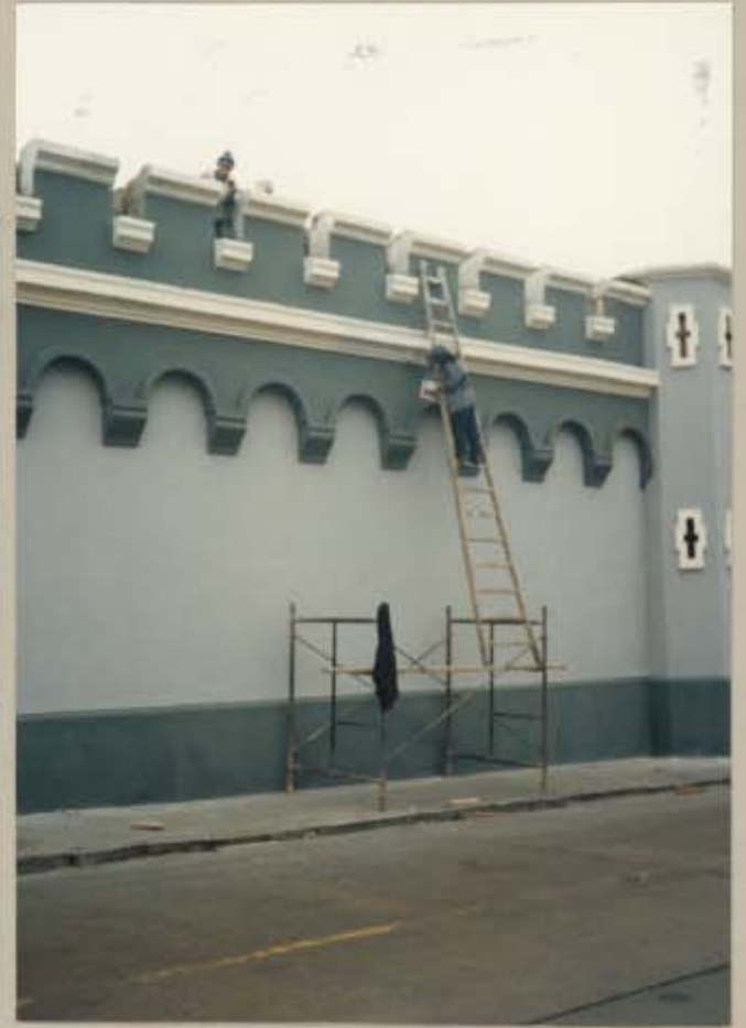
Resultado del trabajo de intervención en la 2da torreta de fachada.
