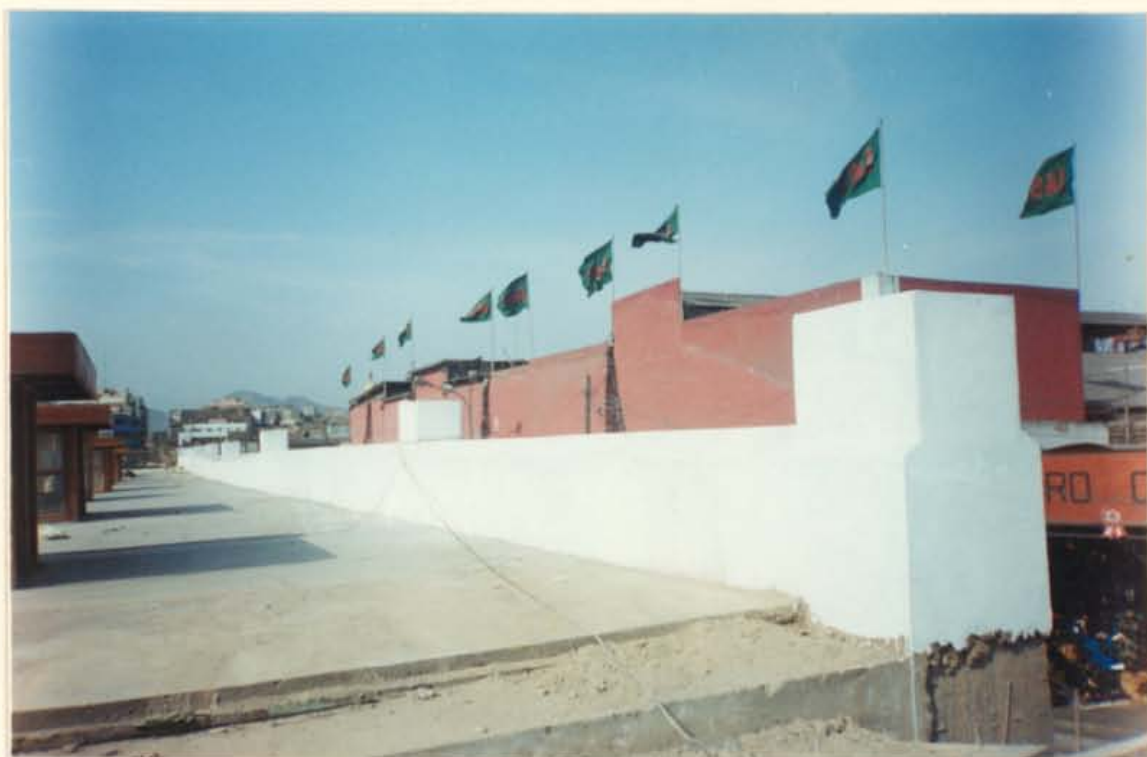
RESTITUCIÓN DE COBERTURAS DE AMBIENTES 104 Y 105 INTERVENCIÓN DE PARAPETO EN MUROS COLINDANTES CON EL JIRÓN ANDAHUAYLAS MEDIANTE TRABAJOS DE RESTITUCIÓN, CONSOLIDACIÓN , ENLUCIDO E IMPRIMADO.
