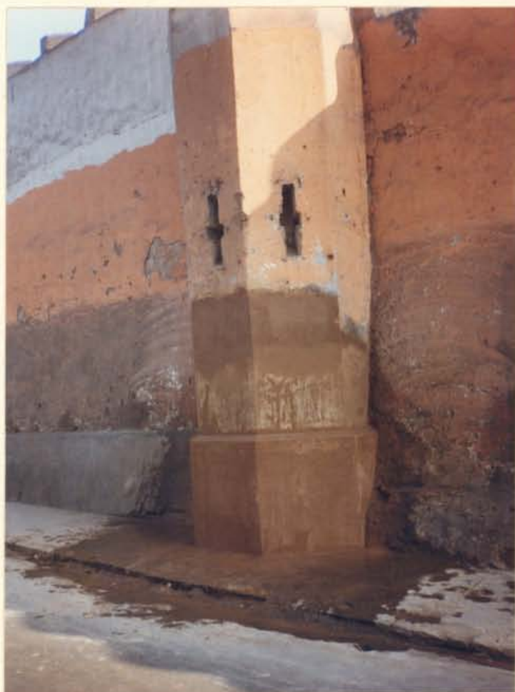
RESTITUCIÓN DE MOLDURAS MEDIANTE TARRAJA SOBRE CAJECERA DE BASE EN TORRETA - TRABAJO CONCLUIDO EN TORRETA.
