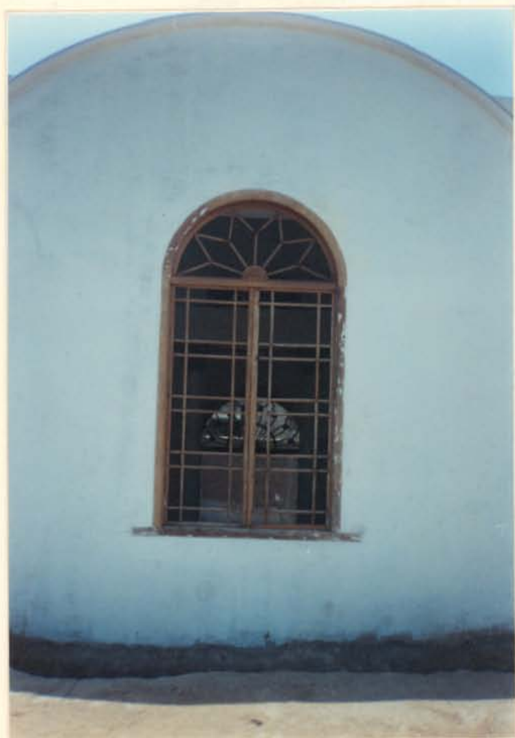
RESTAURACION DEL PORTON DE DOS HOJAS EN ACERO PRINCIPAL DE CAPILLA. VENTANA CON ARCO DE MEDIO PUNTO, RESTAURADO UBICADO EN MURO YESERO.
