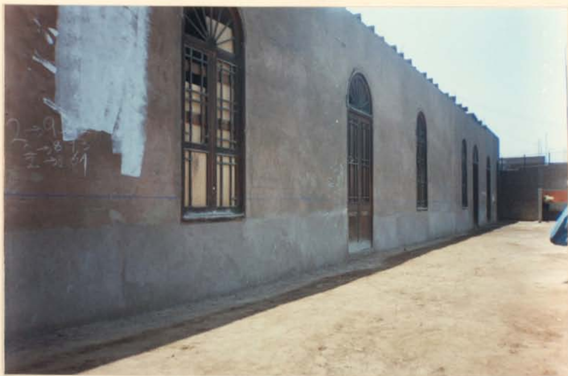
IMPERMEABILIZACIÓN DE CEMENTO Y SOBRECIMIENTO EN LINDERO EXTERIOR ASIMIENTOS 111 AL 114, NÓTESE LA DIFERENCIA DE TIERRA SECA Y SALTROSA PROCESO DE CONSTRUCCIÓN DE LAVADERO (VBLE. PROVISIONAL)
