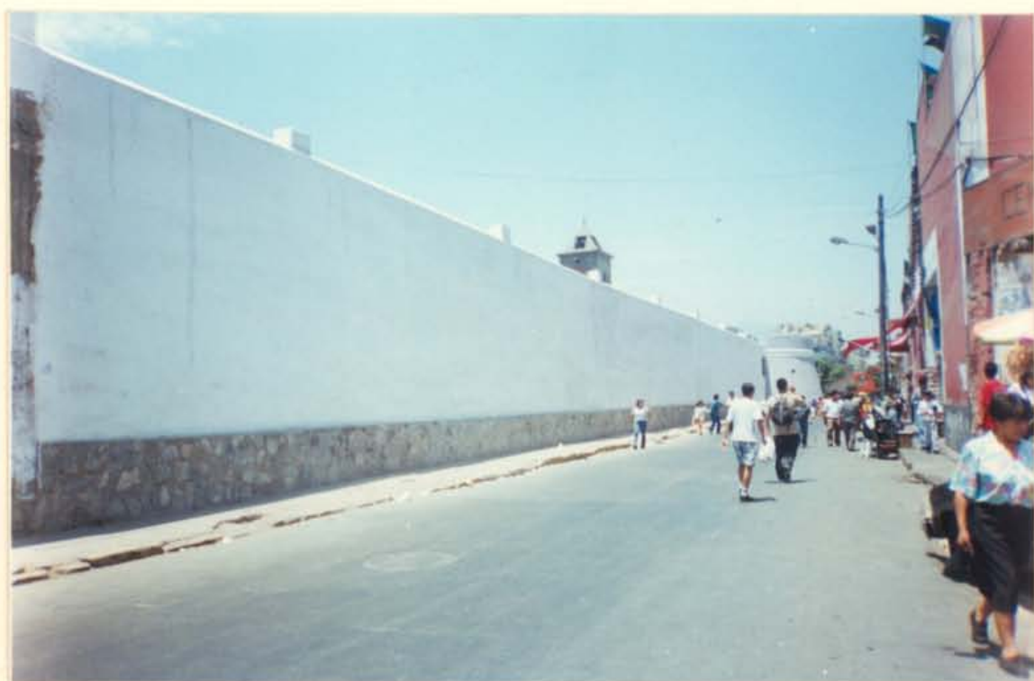
TOMA FOTOGRAFICA DE AMBOS EXTREMOS DEL JIRON ANDAHUAYLAS. SE OBSERVA CONSOLIDACION, ENLUCIDO E IMPRIMADO DE MUROS, ASIMISMO RESTITUCION DE PARAPETO PARTE ALTA. DE MURO
