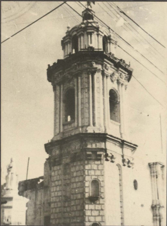
2. PRIMER - SEGUNDO - TERCER CUERPO DE LA TORRE
