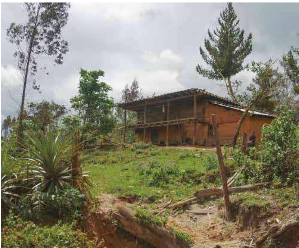
Las galerías en el frontis de la construcción son representativa del estilo arquitectónico republicano. Generalmente están asentadas en la parte baja y fondo del valle. Foto: Ministerio de Cultura.
