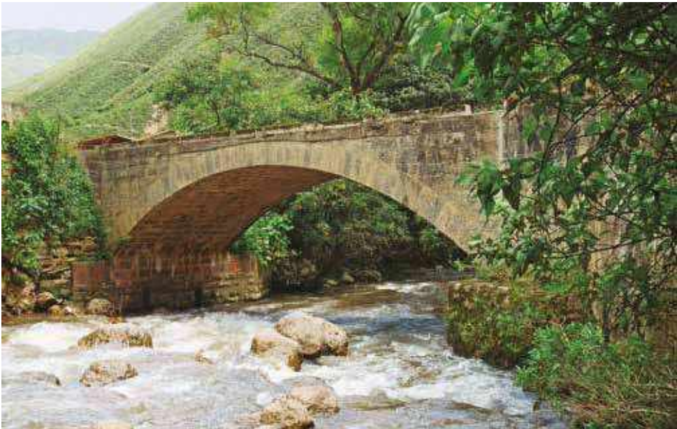
En cauces más estrechos del Utcubamba se han levantado puentes de acceso. En la foto se presenta puente de origen colonial. Foto: Ministerio de Cultura.
