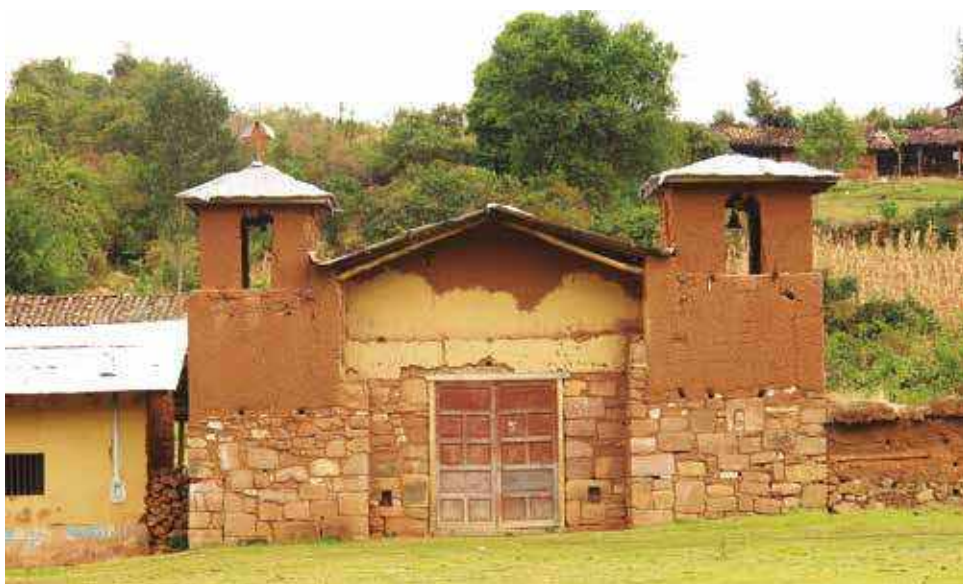
Infraestructura Colonial Republicana en Cochabamba – Chachapoyas. Foto: Martín Chumbe.
